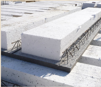
Solai interpiano in predalles gettato in opera
